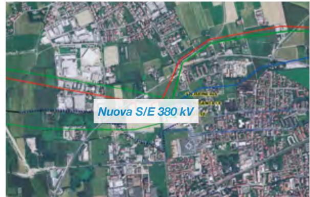
Interramento degli elettrodotti 132 kV nei pressi della nuova sezione 380 kV di S/E Magenta
