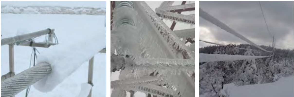
FIGURA 24 Manicotti di ghiaccio su conduttore e danni causati dalla nevelghiaccio
